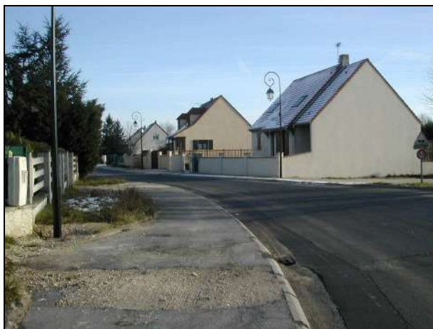
Extensions pavillonnaires à l'entrée de Rouvres.
